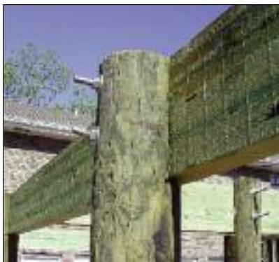
Viga de madera laminada tratada a presión
