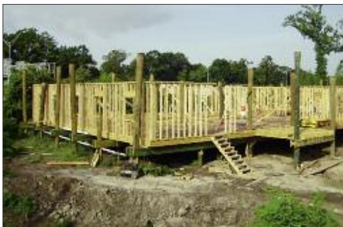
Pilotaje de madera rolliza y vigas para suelo de madera laminada
