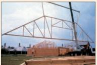
對於鋸材椽條、天棚擱栅或木桁架等構件,南方松是 最佳的屋面系統材料,能够承載較重的重力荷載以及 强風荷載。
