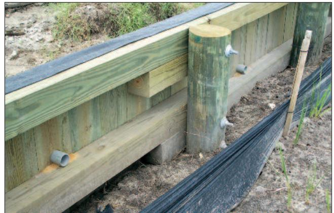
**NOTA:** Si es posible, brinde una escollera de protección en la base del muro de contención para evitar que ocurra erosión y socavación de convergencia.
