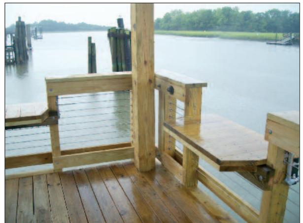
Los cables de acero inoxidable se pueden utilizar para los pasamanos en lugar de las barandas de madera de 2"x6". Siga los lineamientos del fabricante del sistema de barandas de cable de acero para la instalación correcta.
